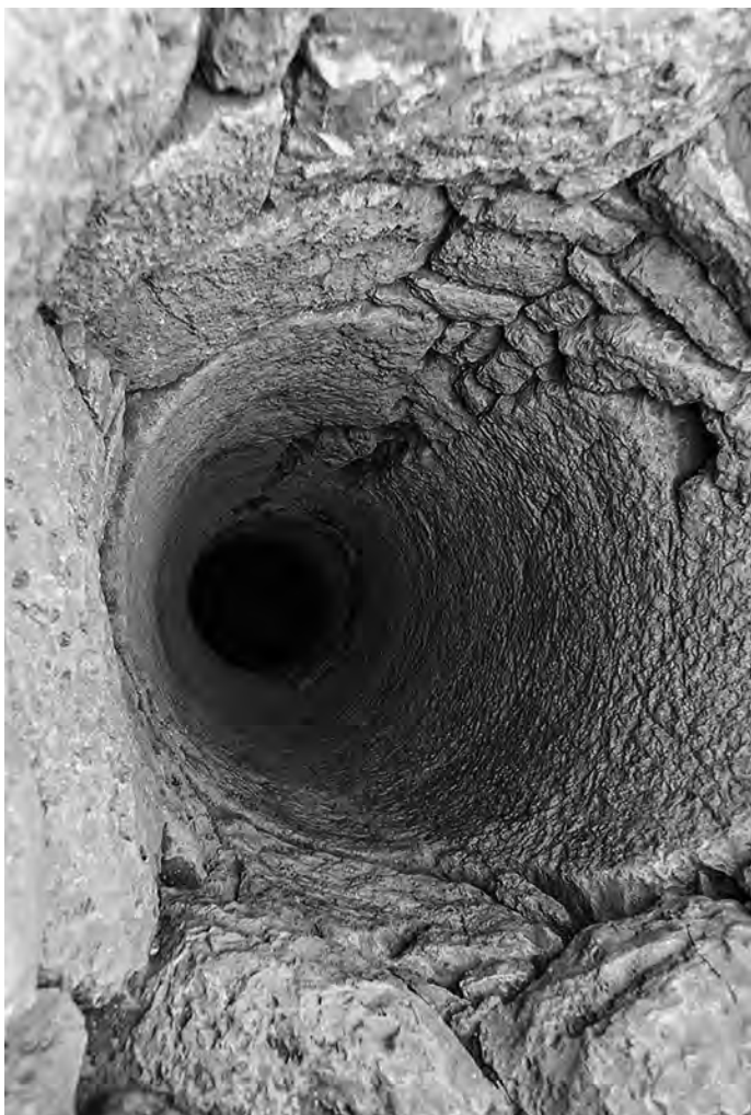
Fig. 6 Vue du puits du local K3 (St122)
